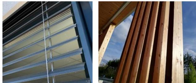
Um sommerliche Überwärmung in Gebäuden und den damit verbundenen Kühlenergiebedarf möglichst gering zu halten, stellen unterschiedliche Verschattungsmöglichkeiten von transparenten Bauteilen eine geeignete Lösung dar. Nicht alle Sonnenschutzsysteme sind für jedes Gebäude geeignet. Dieses Informationsblatt listet unterschiedliche außenliegende Systeme mit deren Vor- und Nachteilen auf.
